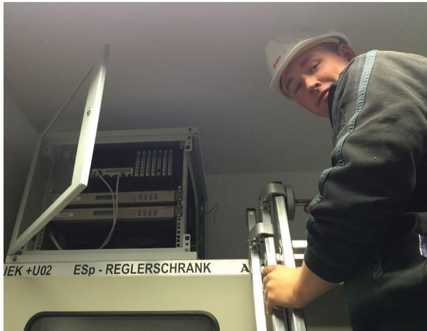
Abbildung 3.13: M. Sc. Przemyslaw Trojan bei PMU-Installationsarbeiten
