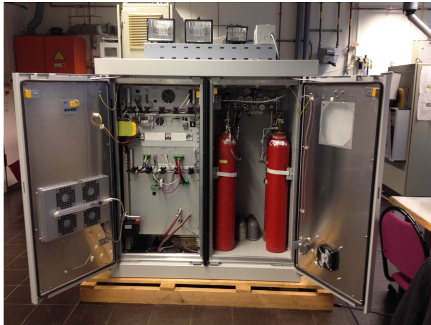
Abbildung 3.18: BZ-USV im LENA Labor. Auf der Anlage steht die Last (Leistung der Strahler 950 W).
